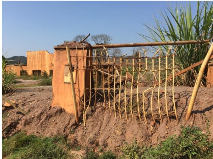
Figura 14 - Imagem do subdistrito de Bento Rodrigues após o desastre
