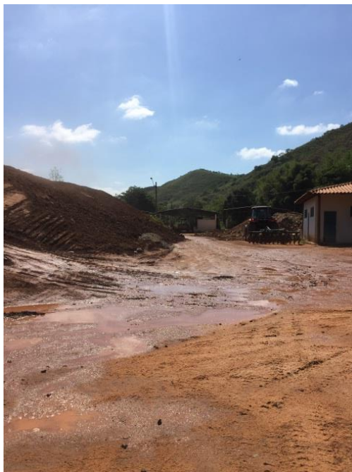
Figura 37 - Centro de exposições e montes de terra (lama) acumulados em Volta da Capela
